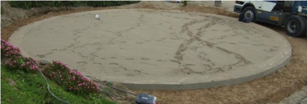
BASE DE ARENA CON ANILLO DE CONCRETO
